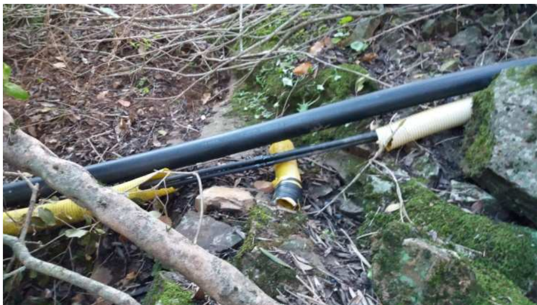
Imagen 7 Tramo en superficie. Protecciones en mal estado
